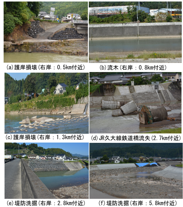
写真-1 平成29年7月九州北部豪雨による災害の例
