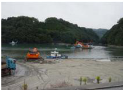
図-2 浚渫状況(相模湖)
