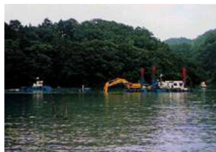
図-3 フラッシュ排砂の様子
